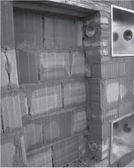
FIG. 12 Instalación empotrada completa
