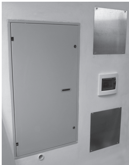
FIG. 12 Encastrement complet
