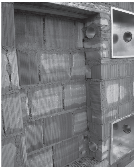
FIG. 12 Installazione ad incasso completa
