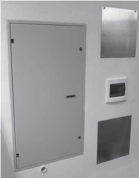
ABB. 12 Abgeschlossene Installation mit Einbau
