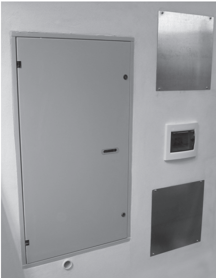
FIG. 12 Instalación empotrada completa
